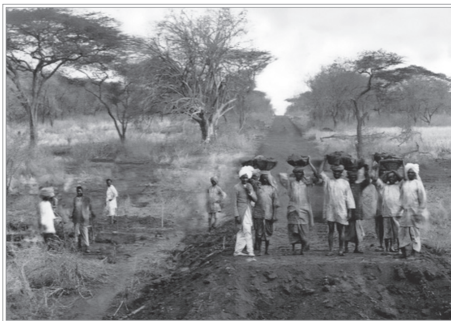
Indičtí kuliové při stavbě železnice
