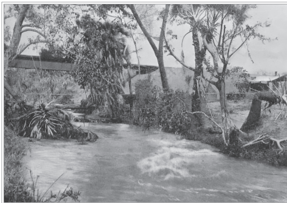
„Řeku překlenoval provizorní most“
