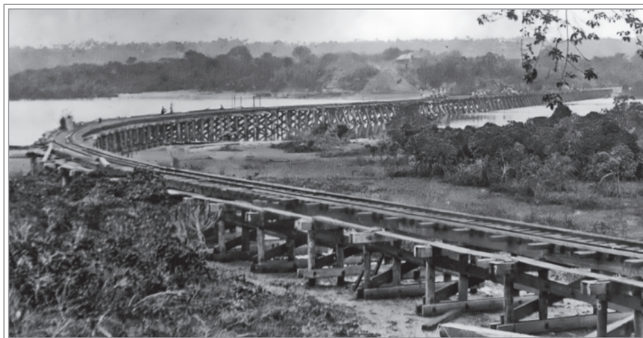
Trať spojující ostrov Mombasa s pevninskou Afrikou
